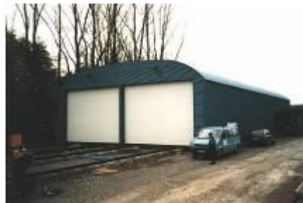
Nutzung als Eisenbahndepot
